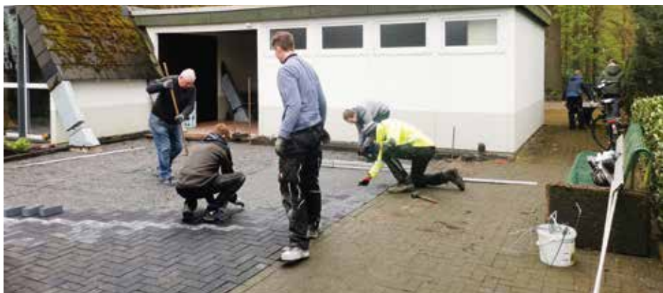
Arbeitsgruppe bei den Pflasterarbeiten in Hochmoor
